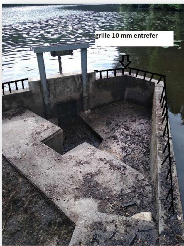
Ce plan d'eau est équipé d'un déversoir de crue en rive gauche. Le déversoir permet d'évacuer un débit estimé à 6,2 m<sup>3</sup>/s correspondant environ à une crue d'une période de retour 100 ans. Le seuil du déversoir de crue 83 cm en dessous du niveau de la chaussée sur la digue constitue le niveau légal de la retenue. Un repère fixe et invariable est matérialisé selon les modalités précisées à l'article 12.
